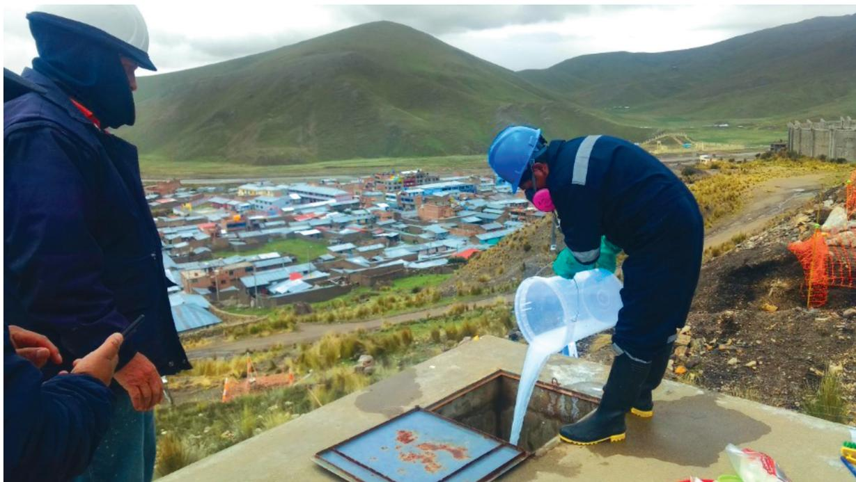
**Figura 10.** Antauta: clorando el tanque del reservorio del sistema de agua potable. Foto: Agualimpia.
