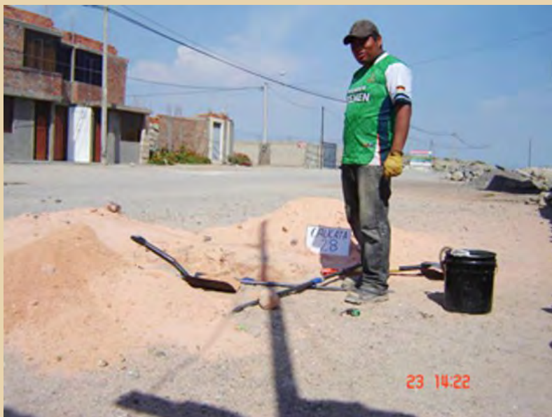
Ejecución de calicatas para conocer el tipo de suelos del trazo del colector – Estudio Técnico, Cerro Colorado, marzo de 2011
