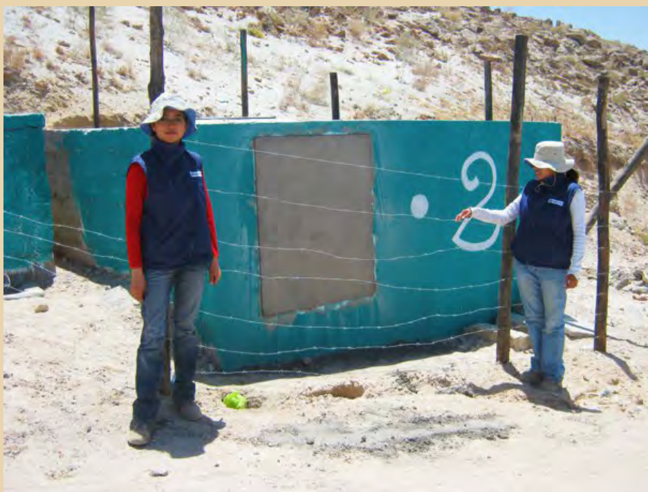
Tarrajeo para mural presentado por las promotoras técnicas de Agualimpia en un pozo que cuenta con un cerco perimétrico de protección. José Luis Bustamante y Rivero, Cerro Colorado, octubre de 2012
