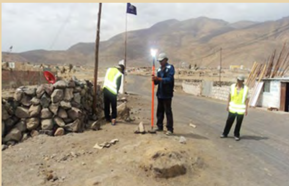
Levantamiento topográfico del trazo del colector - Estudio Técnico, Yura, octubre de 2011
