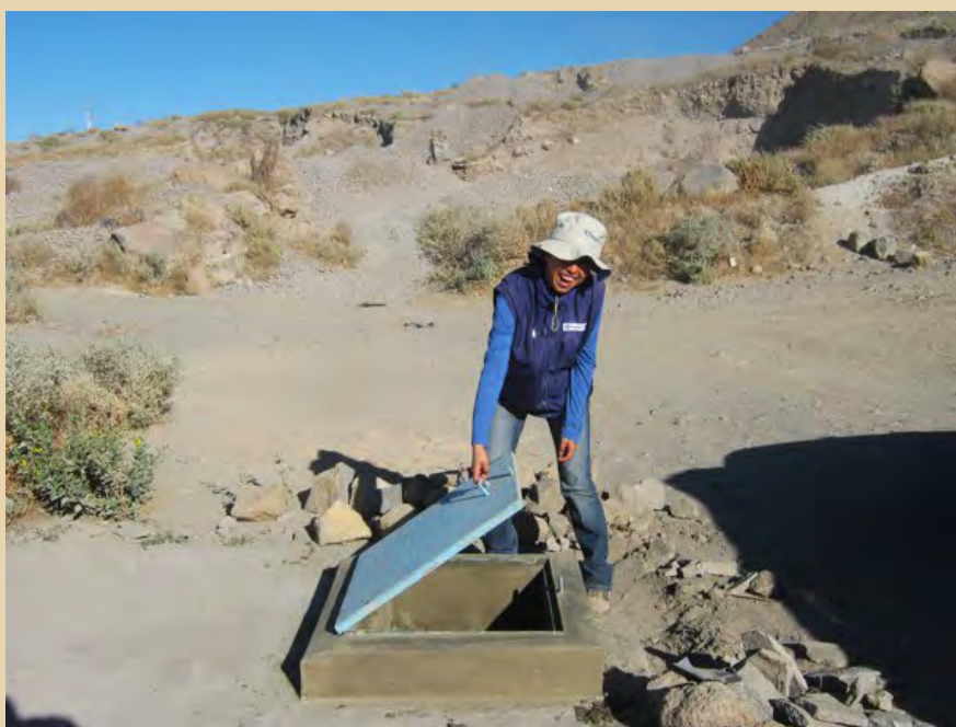
La promotora técnica para la intervención en agua presenta una nueva tapa instalada en un pozo comunal. Cerro Colorado, octubre de 2012
