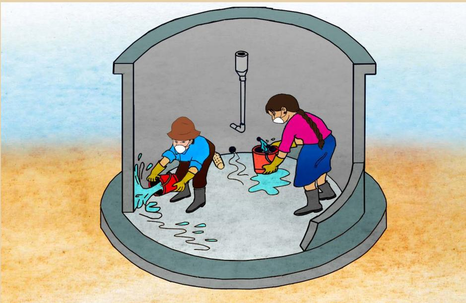
6. Abrir la válvula de ingreso de agua, lo suficiente como para enjuagar con abundante agua el tanque de almacenamiento y dejar salir el agua sucia por el tubo de limpia, terminado la actividad cerrar la válvula de ingreso y colocar el dado móvil.
